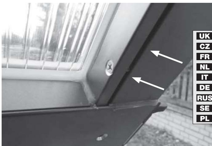
**UK** GROOVE FOR PLACING THE LAMELLA
