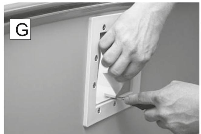
Mitunter wird die Dichtung ab Werk als Doppeldichtung ausgeliefert. In dem Fall sind die beiden Wandungen voneinander zu trennen und als Einzeldichtungen zu behandeln.
