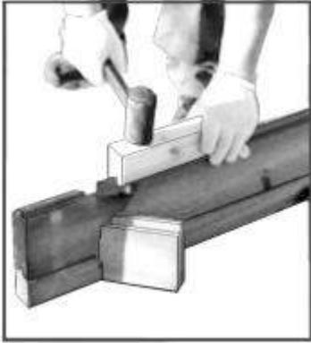
Um die Befestigung der Nut und Feder präzise ausführen zu können und die Feder nicht zu beschädigen. Empfehlen wir wie auf dem Foto zu sehen ein Holzklötzchen zu verwenden.
