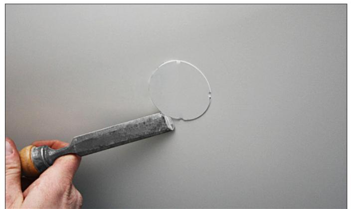
Unabhängig davon müssen die Kanten stets mit Korrosionsschutzmittel oder Kunststofffarbe behandelt werden.
