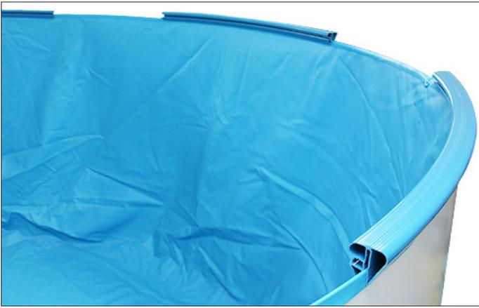
Erst nach gleichmäßiger Ausrichtung der Folien-Schweißnähte den Handlauf komplett montieren.
