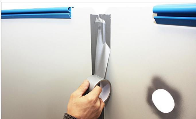
Zum Schutz der Innenhülle vor Beschädigung sollte das Steckprofil innen mit Klebeband überklebt werden.
